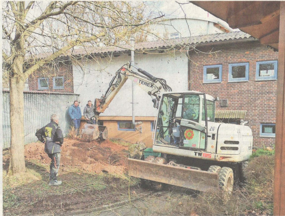
Der Bagger beißt erstmals zu: An drei Stellen rund um die Jugendverkehrsschule werden Proben des Erdreichs entnommen, um Rückschlüsse auf die Standfestigkeit des Untergrunds für den geplanten Neubau ziehen zu können. FOTOS: VERKEHRSWACHT
